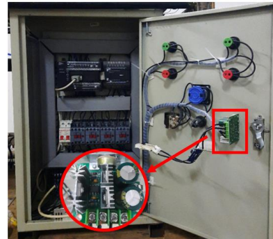
Gambar 7. Pemasangan kontrol PWM
