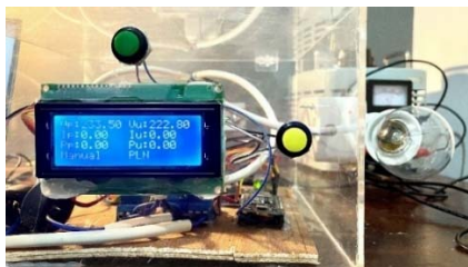
Gambar 16. Kondisi ATS mode manual PLN saat PLN saat PLN undervoltage (beban tidak disuplai)
