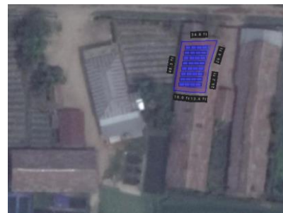
Gambar 7. Panel Surya PLTS Terpusat
