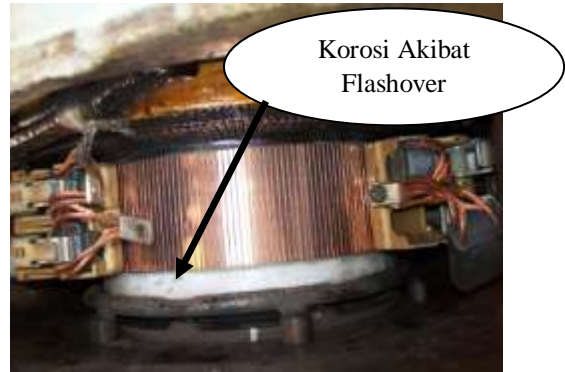
Gambar 17. Akibat Flashover pada Motor Traksi. [14]
