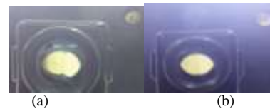
Gambar 23 Skala warna minyak isolasi transformator pada sampel 4 (a) sebelum purifikasi, dan (b) setelah purifikasi
