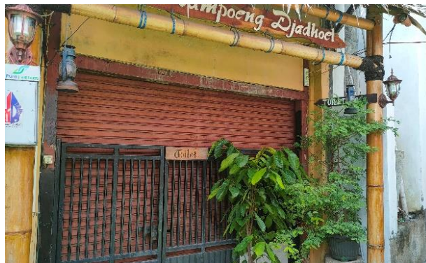
Gambar 15. Kondisi Toilet Kampung Batik (Analisis, 2022)
