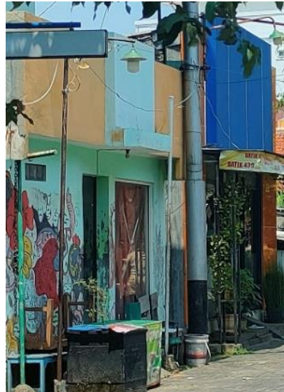
Gambar 8. Lampu Penerangan Jalan di Jalan Batik Gedong (Dokumentasi, 2022)
