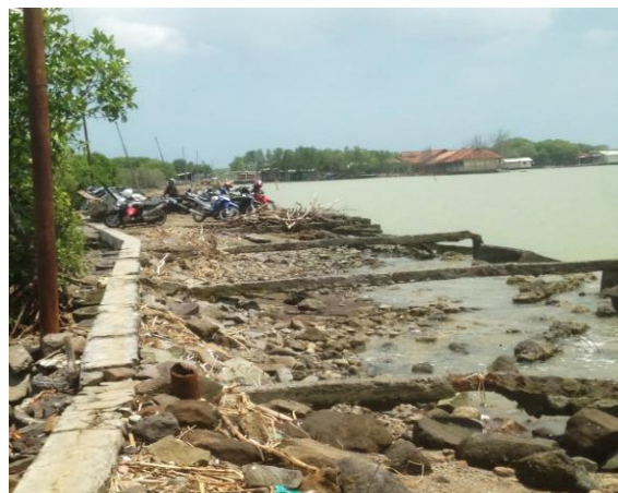
Gambar 8. Hilangnya Akses Jalan di Desa Bedono (Analisis, 2019)
