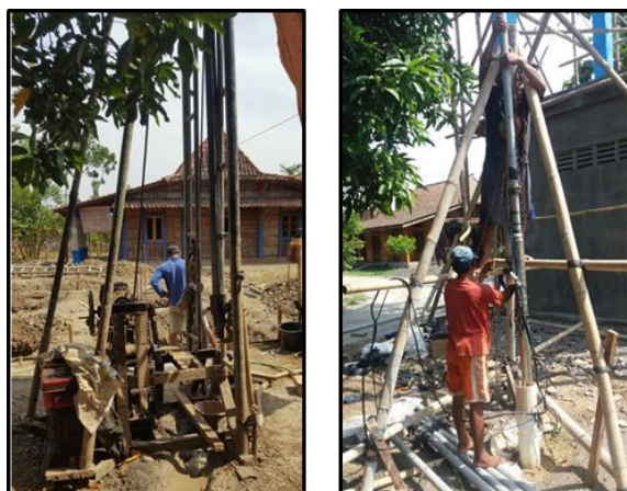
Gambar 3. Proses Konstruksi Pembangunan Sarana Prasarana (www.pamsimas.org)
