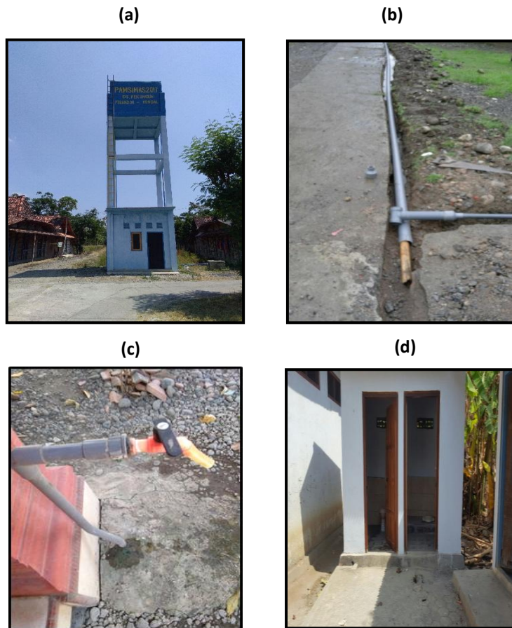
Gambar 4. (a) Tower Air Pamsimas, (b) PVC Pamsimas, (c) Kran Air Pamsimas, (d) Jamban Sehat Sekolah (Observasi, 2019)
