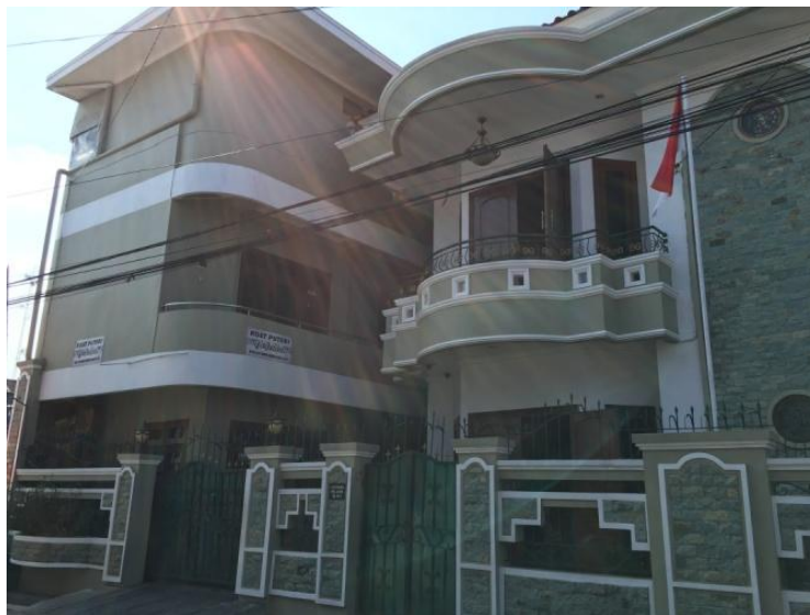
Gambar 3. Rumah yang dijadikan Kos-kosan (Dokumentasi Penyusun, 2016)
