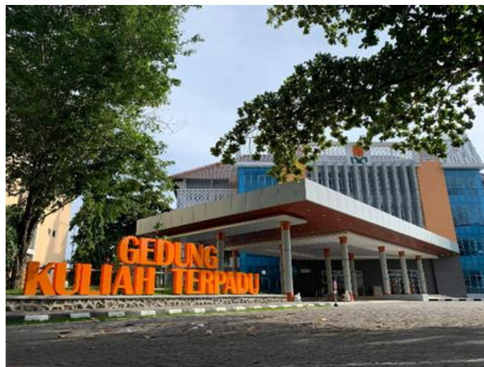
Gambar 1. Gedung Kuliah Terpadu UIN Sunan Kalijaga Yogyakarta
