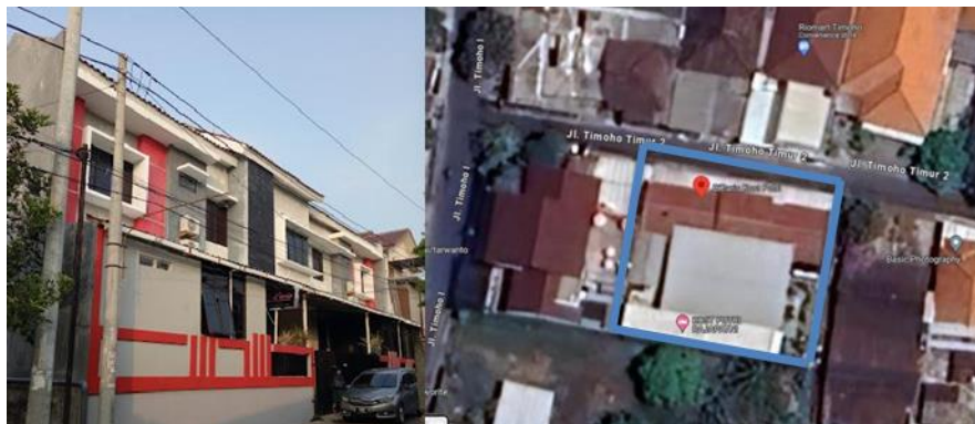
Gambar 1. Fasad dan Lokasi Bangunan D'Paris Kos Putri
