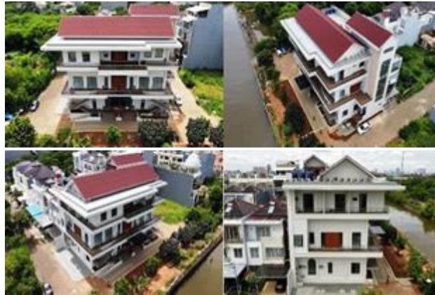
Gambar 3. Dokumentasi objek penelitian (Kontraktor PT. ADEC)
