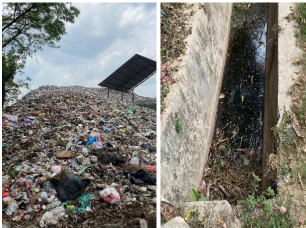
Gambar 1.5 Kondisi Landfill dan Saluran Air
