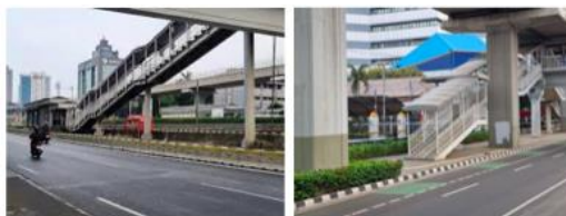
Gambar 1 Halte yang Tidak Ramah Disabilitas
