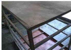
Gambar 5 Kerangka *bekisting*
