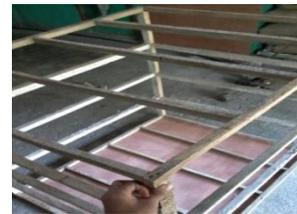
Gambar 4 Kerangka kayu (kerangka *bekisting*)
