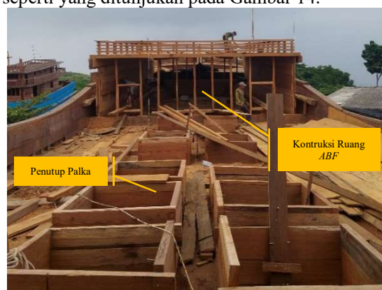
Gambar 14. Kontruksi bangunan ABF
