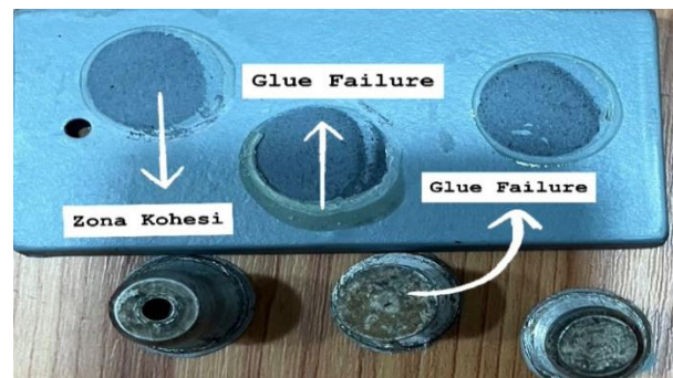
Gambar 14. Zona Kegagalan pada Pull-Off Test
