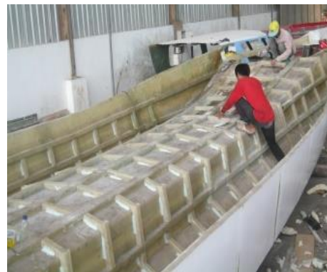
Gambar 1. Kontruksi lambung katamaran dengan menggunakan profil U
