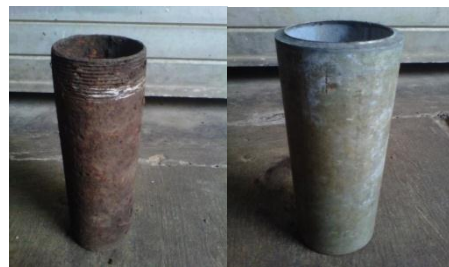
Gambar 2. Pipa korosi dan Pipa baru
