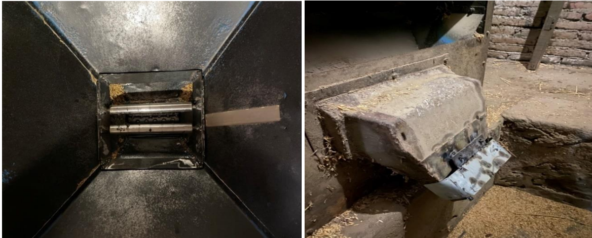
Gambar 5. Pemasangan Magnetic Trap di UD. Sumber Makmur
