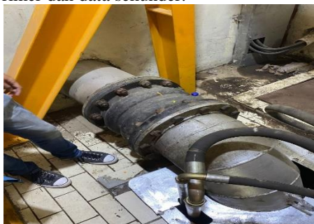
Gambar 1. Satu unit Hydraulic Axial Pump Berkapasitas 250 Liter per Detik
