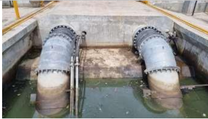
Gambar 1. Unit Hydraulic Axial Pump Berkapasitas 2000 Liter per Detik
