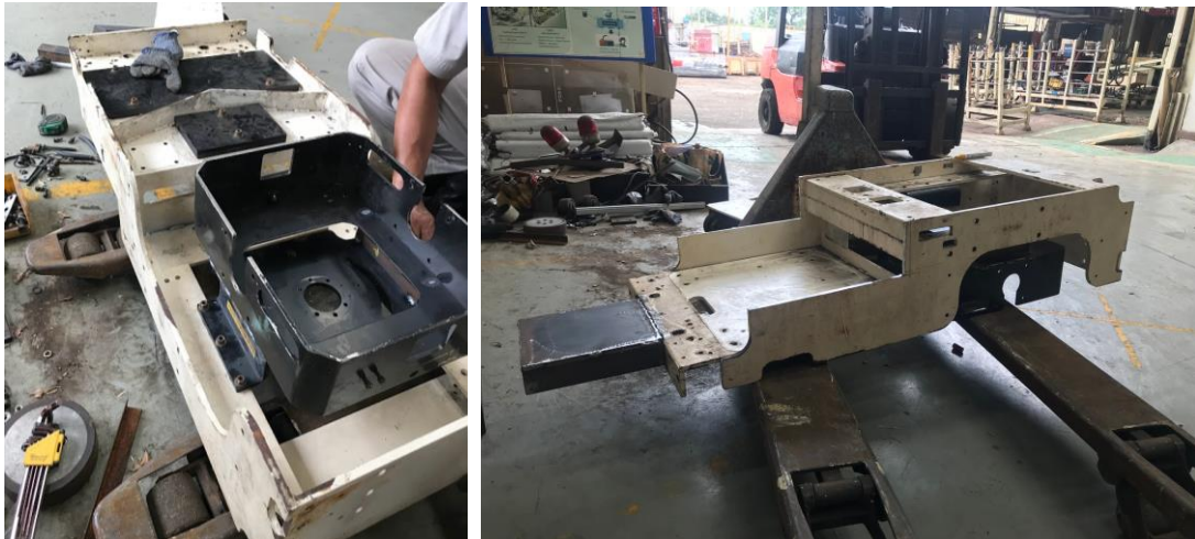
Gambar 20. Hasil instalasi dan fitting motor bracket pada rangka utama.
