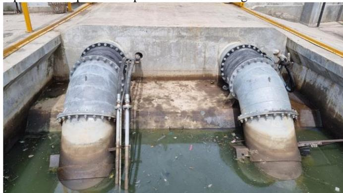
Gambar 1. Dua Unit *Hydraulic Axial Pump* Berkapasitas 2000 Liter per Detik
