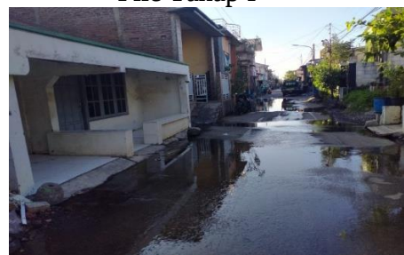
Gambar 3 Rembesan Air Laut dari Sheet Pile Tahap I
