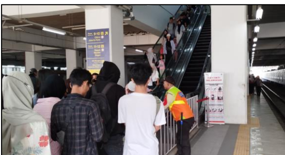
Gambar 8. Kerusakan Eskalator Stasiun Transit Manggarai
