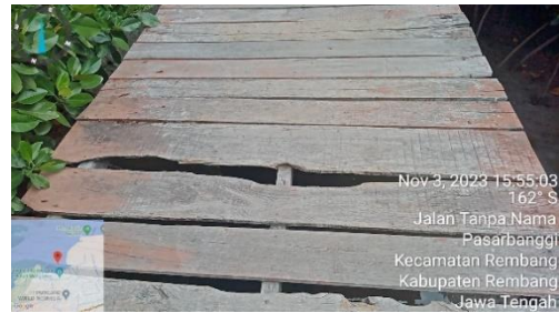
Gambar 6. Beberapa Bagian Jembatan Berlubang
