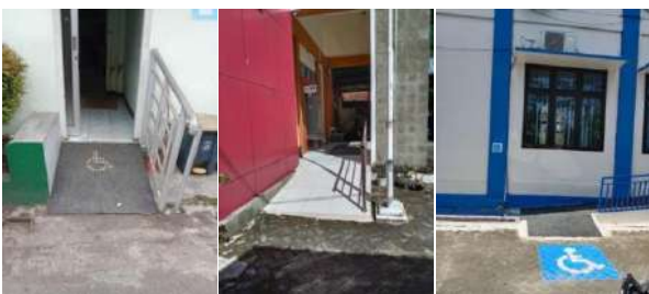
Gambar 2.1 Fasilitas Ramp/Bidang Miring di Gedung Pemerintah Kebumen
