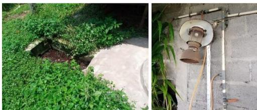
Gambar 1. Unit Biogas yang Rusak
