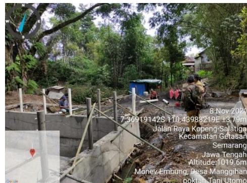
Gambar 3. Monitor Evaluasi Rutin Lapangan dalam Proses Pembangunan Embung
