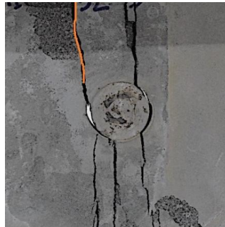
Gambar 6. Pola Retak pada Benda Uji Mortar-Inklusi
