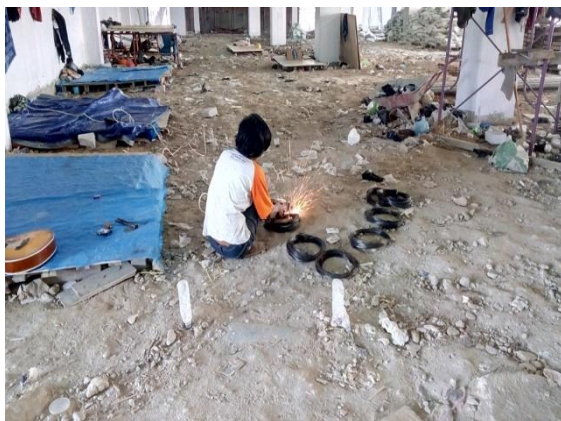
Gambar 2. Pekerja dan Tukang Tidak Menggunakan APD
