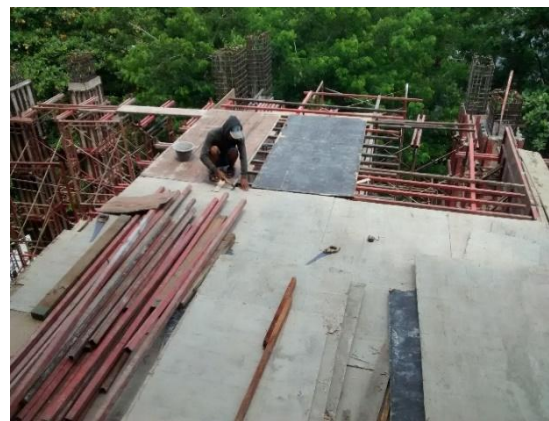
Gambar 2. Pekerja dan Tukang Tidak Menggunakan APD
