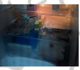
Gambar 4. Bunga es yang tebal karena tidak dilakukan pemeliharaan refrigerator berupa defrosting.Seharusnya defrosting dilakukan secara berkala setiap satu bulan atau bila ketebalan es >0,5 cm.
