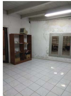
Gambar 4. Rak Penyimpanan Barang Pengunjung
