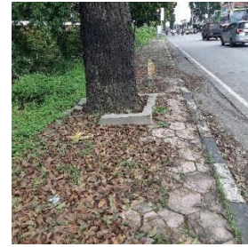
Gambar 28 Trotoar di Jalan Soekarno Hatta (sumber: dokumentasi pribadi)
