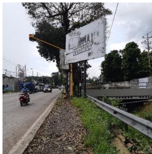
Gambar 33 Lampu lalu lintas warna kuning dan pagar pengaman jalan (sumber: dokumentasi pribadi)
