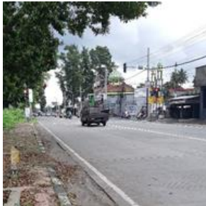
Gambar 26 Lampu Lalu Lintas Persimpangan Jl. Soekarno Hatta dan Jl. Joko Tingkir (sumber: dokumentasi pribadi)
