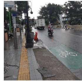
Gambar 29 Trotoar di Jalan Diponegoro (sumber: dokumentasi pribadi)
