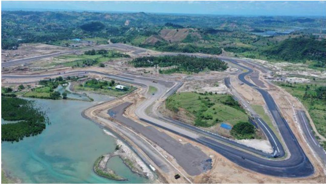
Proses Pembangunan Sirkuit mandalika
