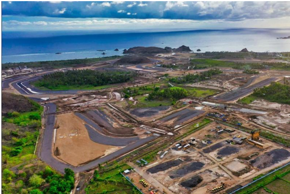
Proses Pembangunan Sirkuit Mandalika
