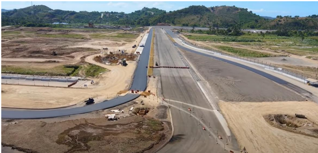
Proses Pembangunan Sirkuit Mandalika
