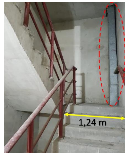
Gambar 17. Lebar tangga dan pressure fan
