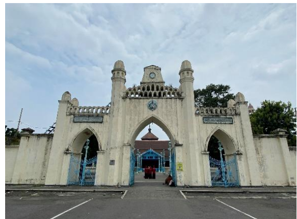
Gambar 15 : Gerbang Masjid Agung Surakarta Sumber : dokumentasi pribadi
