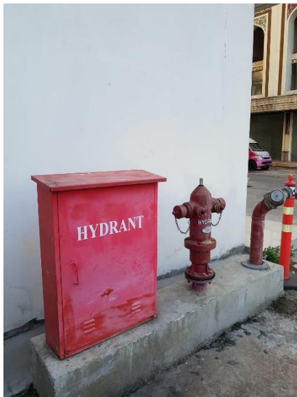
Gambar 10. Penempatan hidran halaman A sumber : Dokumen Pribadi
