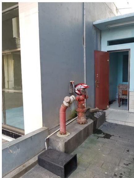
Gambar 11. Penempatan hidran halaman B sumber : Dokumen Pribadi
