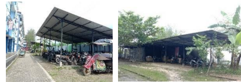
Gambar 19: Area Parkir Rusunawa Kraton Tegal (Sumber: Dokumentasi Pribadi, 2021)
