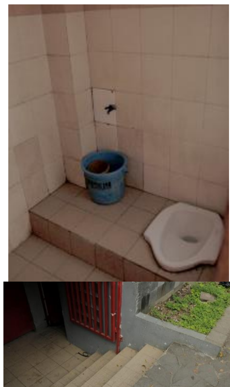
Gambar 17 Kondisi Eksisting Toilet di Taman Pandanaran
