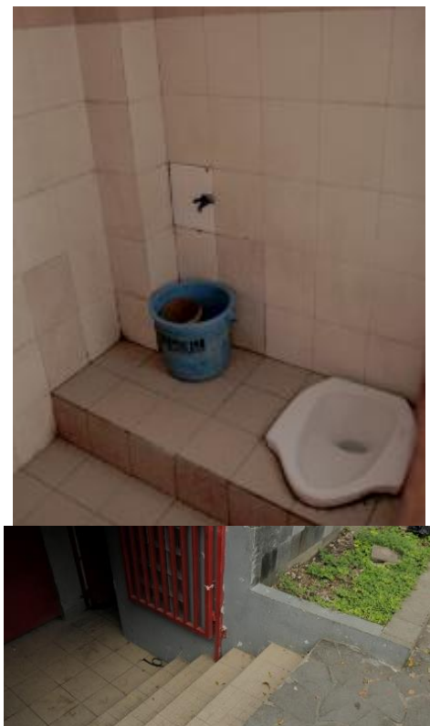
Gambar 17 Kondisi Eksisting Toilet di Taman Pandanaran Sumber : Dokumen Pribadi
