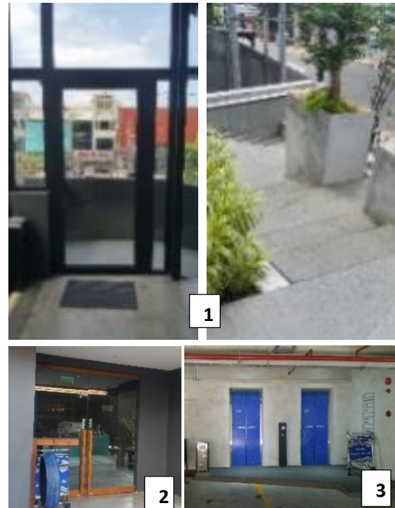
Gambar 9 : Kondisi Pintu Masuk 1,2, dan 3 Sumber : Dokumentasi Penulis
