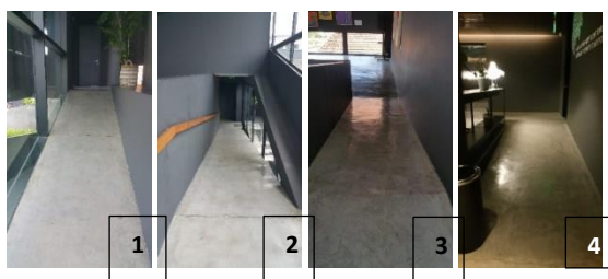
Gambar 12 Ramp Indoor Sumber : Dokumentasi Penulis
