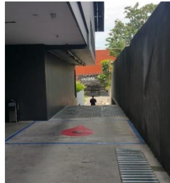
Gambar 4 : Kondisi Drop Off 2 (Sumber : Dokumentasi Penulis)
