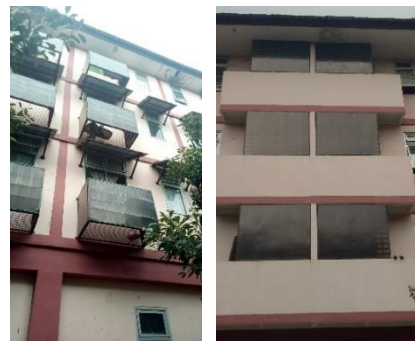
Gambar 4 Balkon A dan B Rusunawa UNDIP Sumber: Dokumentasi pribadi
