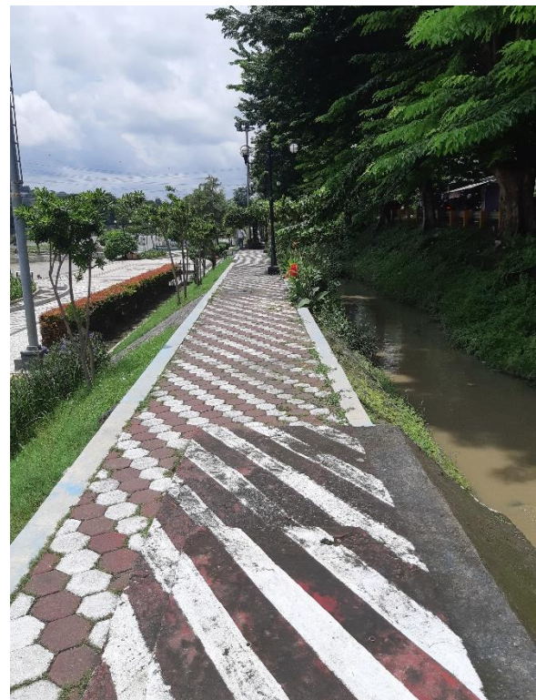
Gambar 3. Kondisi Jalur Pedestrian
