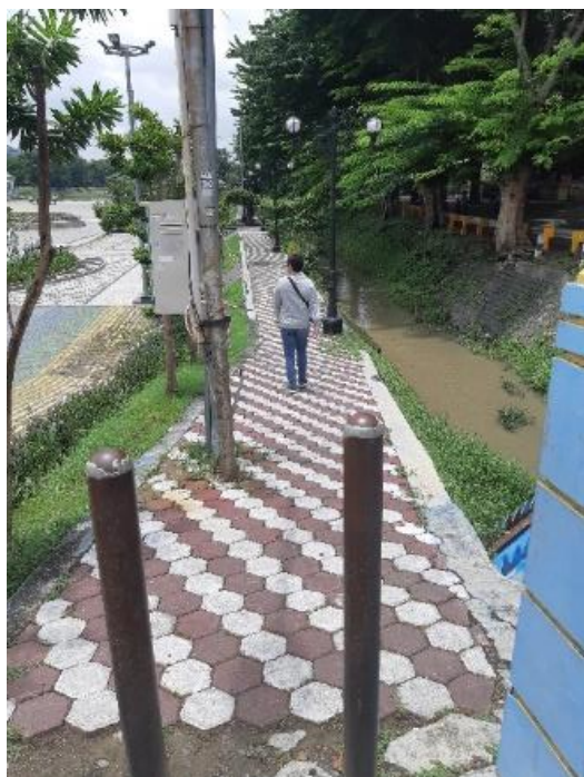
Gambar 4. Kondisi Jalur Pedestrian
