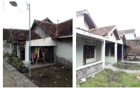
Gambar 8 Kondisi Rumah Warga Kampung Rejosari
