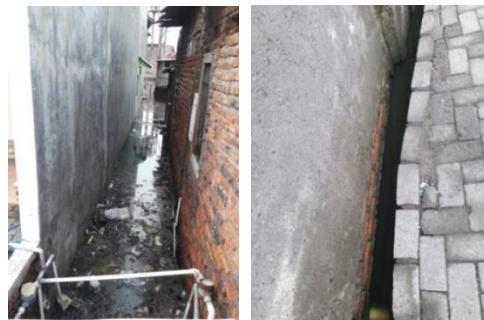
Gambar 9 Kondisi Drainase Kampung Rejosari
