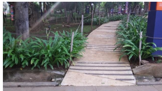
Gambar 6 : Kondisi Jalur Pedestrian 2
