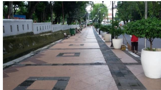
Gambar 5 : Kondisi Jalur Pedestrian 1
