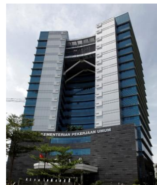
Gambar 1 Gedung Utama Kementerian Pekerjaan Umum
