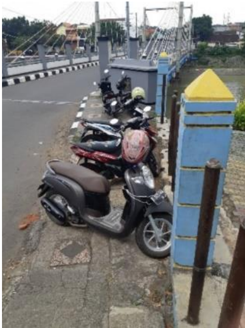
Gambar 8. Kondisi Area Parkir
