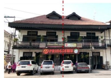
Gambar 6 Keseimbangan pada sisi selatan bangunan (Dokumentasi Peneliti, 2020)
