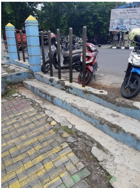
Gambar 9. Kondisi Area Parkir
