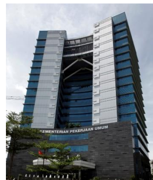
Gambar 1 Gedung Utama Kementerian Pekerjaan Umum
