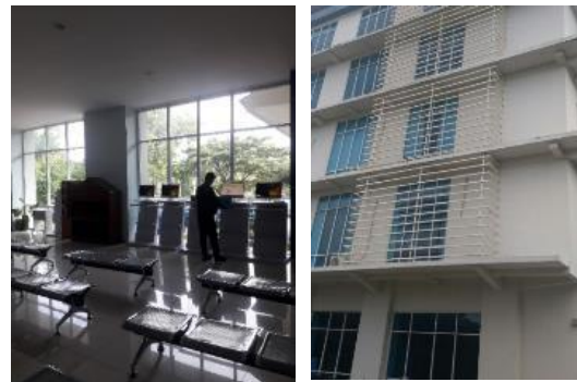
Gambar 10 : 1) Tinggi dinding kaca, 2) Horizontal shading pada bangunan untuk lantai 1 Sumber : Survey lapangan (2020)
