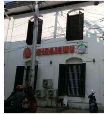
Gambar 12 Dinding Bangunan di Lapangan (Dokumentasi Peneliti, 2020)
