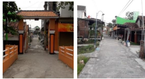
Gambar 7 Kondisi Jalan Kampung Rejosari
