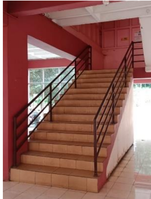
Gambar 2 Tangga timur (kiri), Tangga barat (kanan), Tangga tengah (tengah)
