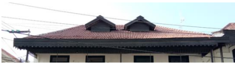
Gambar 10 Atap Bangunan di Lapangan (Dokumentasi Peneliti, 2020)
