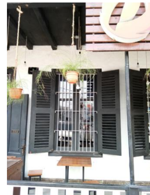
Gambar 14 Salah Satu Bukaan pada bangunan di lapangan (Peneliti, 2020)
