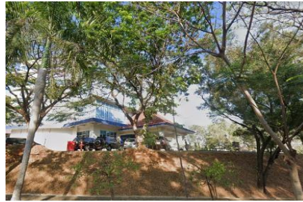
Gambar 6: Vegetasi eksisting di sekitar gedung Dekanat Fakultas Teknik
