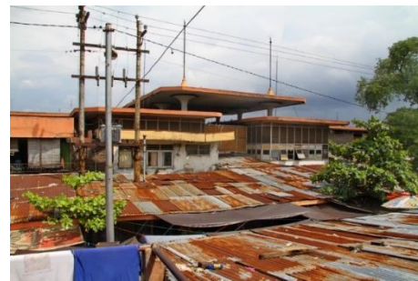
Gambar 4 : fasad utama pasar johar sebelum revitalisasi
