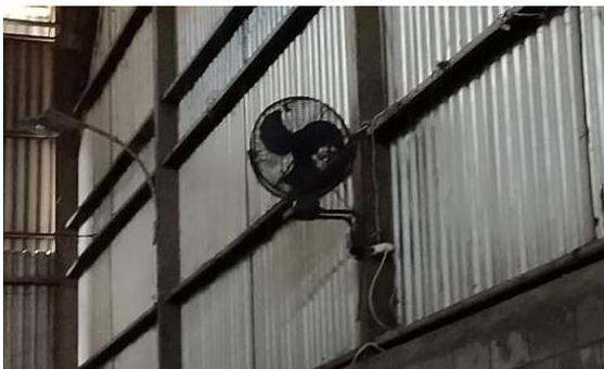
Penghawaan pada lapangan futsal menggunakan penghawaan alami dan buatan , penghawaan alami terdapat pada sisi kiri lapangan dengan adanya bukaan besar di sisi tersebut . Penghawaan buatan menggunakan kipas angin , terdapat 2 kipas angin yang terletak di atas masing-masing tribun , kipas angin berada 3 m di atas tribun .
