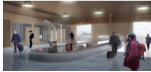
Ruang Pengambilan Bagasi
