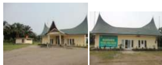
Foto Bangunan Eksisting Bandara Pusako Anak Nagari
