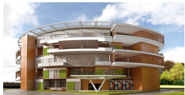
TAMPAK DEPAN BANGUNAN
