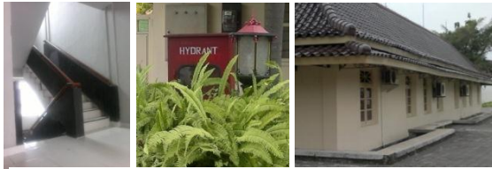
Gambar 13. Sistem mekanikal elektrikal pada kantor gubernur D.I. Yogyakarta
