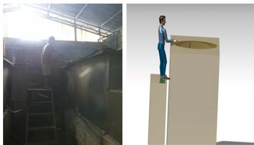
Sebelum Perbaikan Sesudah Perbaikan
